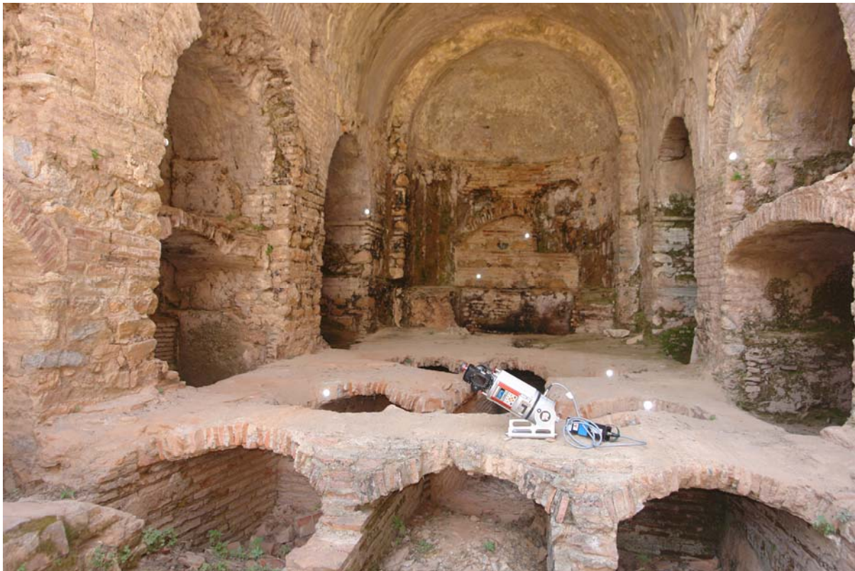
Abb. 1: Bauaufnahme im Apsidensaal des Krypta-Komplexes mit dem 3D-Laserscanner
